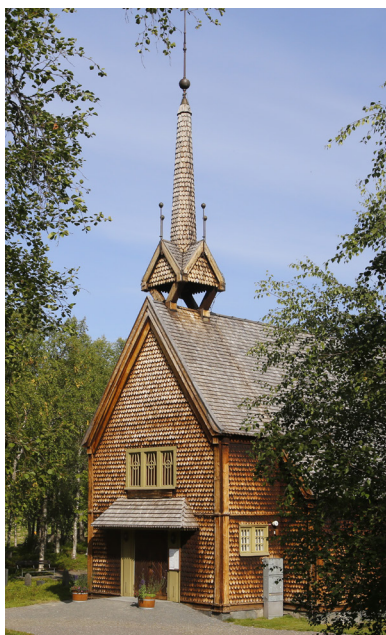
Ammarnäs kyrka byggdes 1910-12 och är täckt med pärt, en fjällpanel som bildar ett fiskfjällsmönster.
