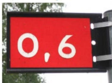
Exempel på godkänd skylt för brandpostanordning
